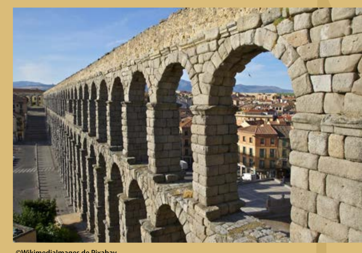
AQUEDUC DE SÉGOVIE (I-II ÈME SIÈCLE)
