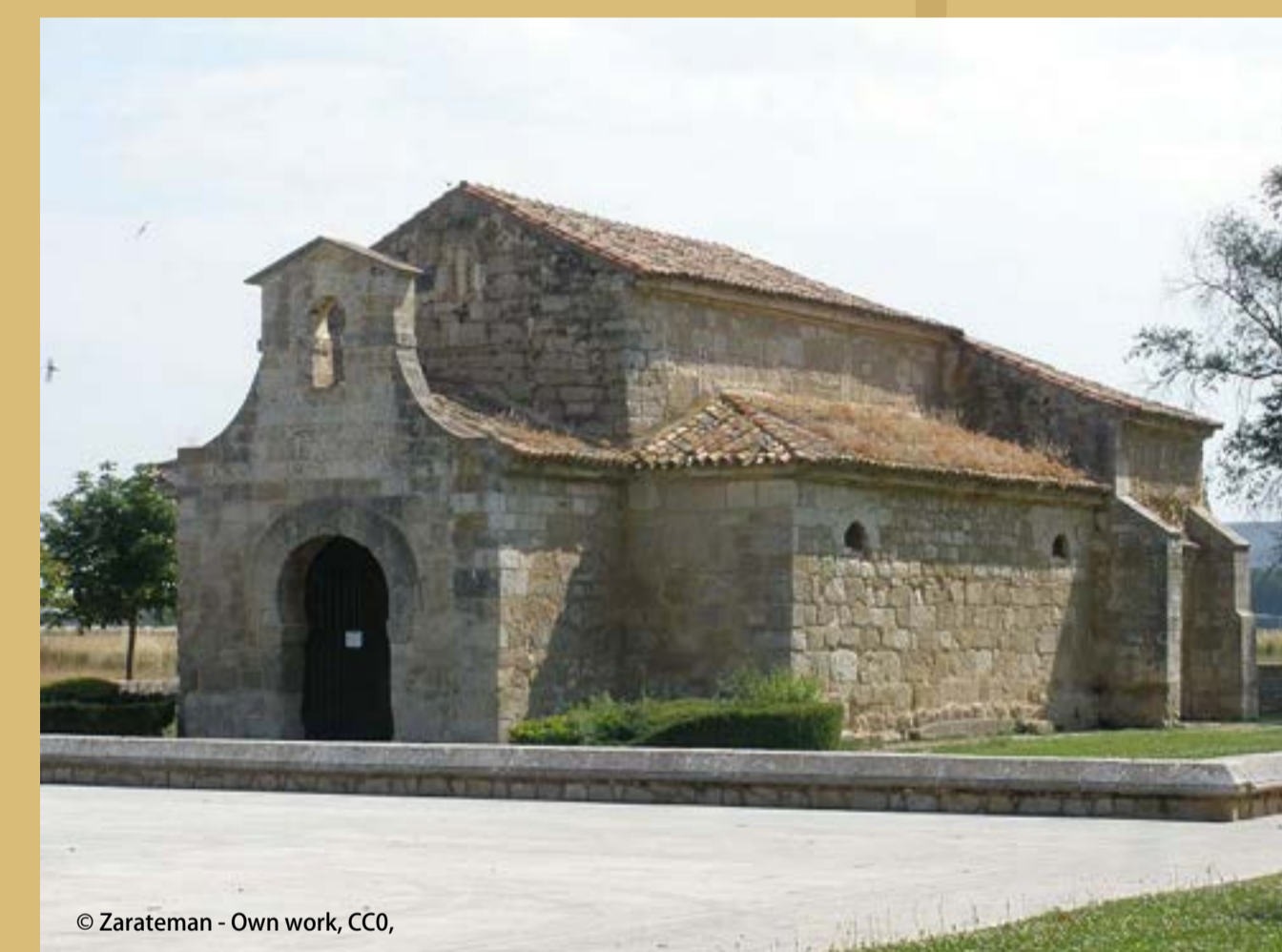
SAN JUAN DE BANOS DE CERRATO : PREMIER MONUMENT WISIGOTHIQUE (VII ÈME SIÈCLE)
